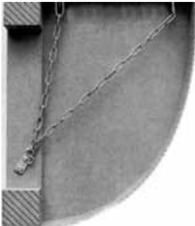
Bild 3-49: Befestigung im Mauerwerk beim Kunststofflichtschacht
