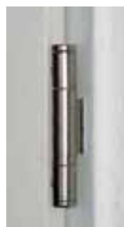
Außenliegende Scharniere stellen ein hohes Risiko dar. Sie können schnell demontiert werden. Eine Tür sollte über zwei bis drei stabile, innenliegende und verschraubte Bänder verfügen. Wenn dies nicht gegeben ist, können spezielle Bandseitensicherungen Abhilfe leisten.
